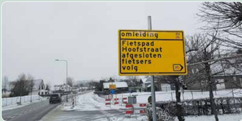
De werkzaamheden duren ongeveer vier maanden. Foto: gemeente Nederweert
