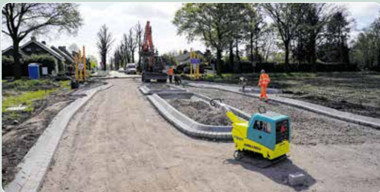
2024: de aanleg van een verkeersplateau met middengeleider bij de komgrens Ospeldijk voor het verhogen van de verkeersveiligheid. Foto: Nederweert24
