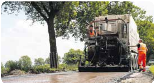
De komende weken vinden diverse onderhoudswerkzaamheden plaats aan straten in onze gemeente. Foto: Nederweert24
