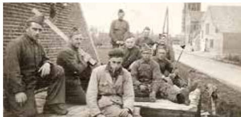
Bij Heine-Tjeu (Loijen) op de Waatskamp in Ospel. Onder leiding van Mathieu Caris (voorop) wordt een bunker gebouwd tegen de boerderij in april 1940.
