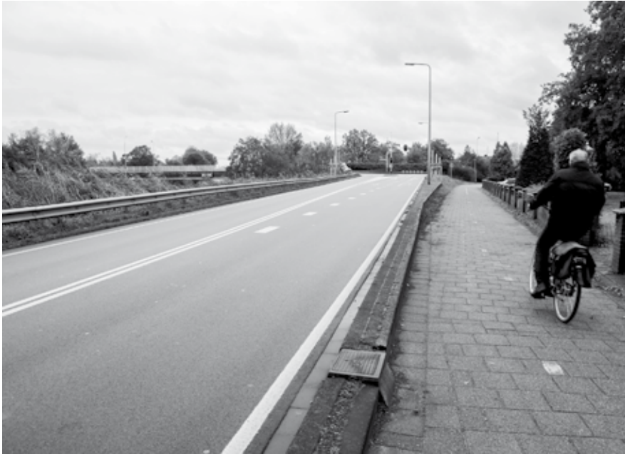
Op deze plek komt de nieuwe fietstunnel onder de N275. Foto: Nederweert24
