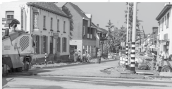
In de Brugstraat en op de N266 wordt aan de weg gewerkt. Foto: Nederweert24
