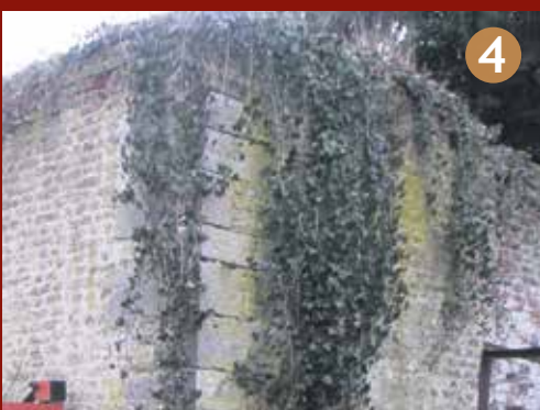
De resten van de noordwestelijke hoektoren zijn voorzien van hardstenen hoekbanden.
